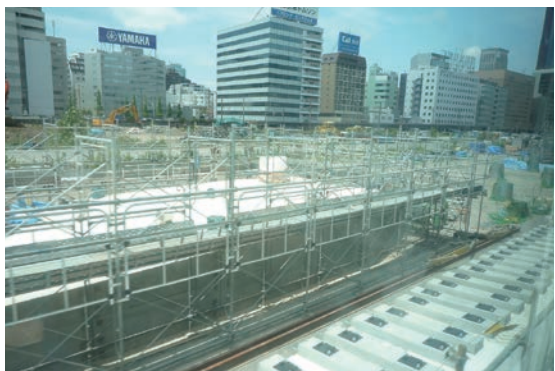
建設工事が始まった当初の高輪ゲートウェイ駅予定地
